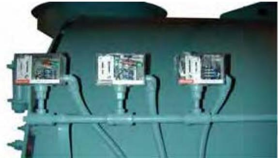
Figura 4-5: Controles de operación de vapor
