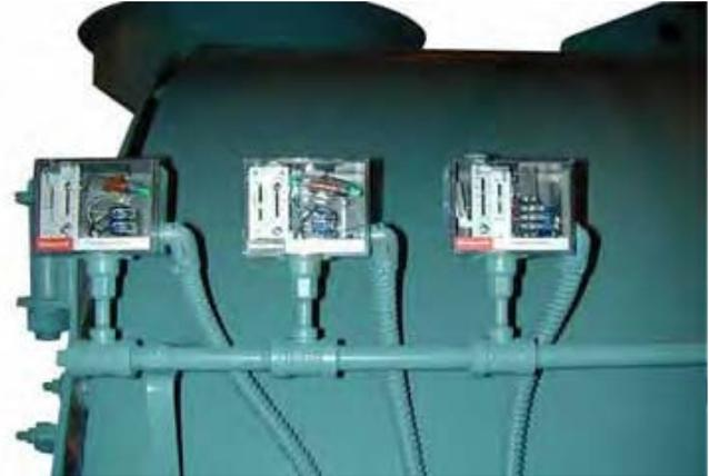
Figura 4-2: Controles de operación de vapor
