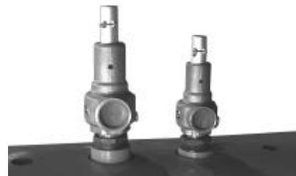
**Figura: 5-7 Válvulas de seguridad**
