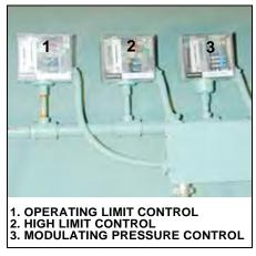
Figure 1-8. Pressure Controls
